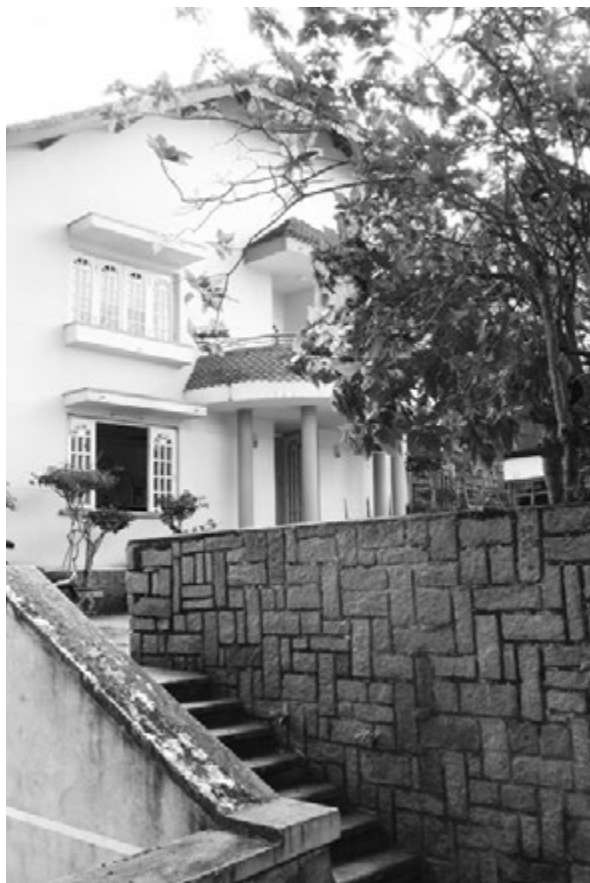
[Biệt thự số 11 đường Hoa Hồng năm xưa, nay đã được xây mới hoàn toàn; là khách sạn Saigon Port, số 17 Huỳnh Thúc Kháng. Ảnh: NVN]
